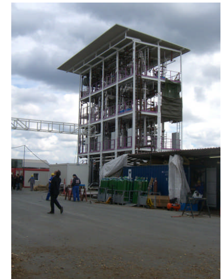
Bio-SNG-Anlage Güssing, Österreich, 1 MWth, April 2008. Qu.: Oettel
